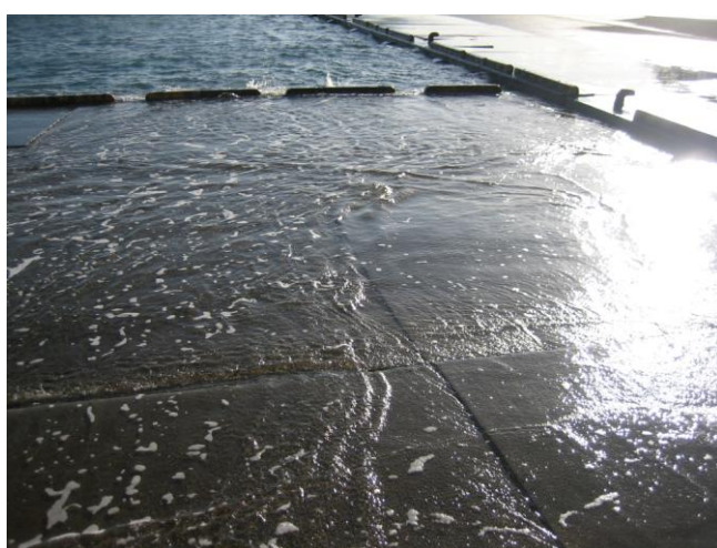
写真⑥；地盤沈下のため、満潮時には海水が浸入 (唐桑半島のとある港)
