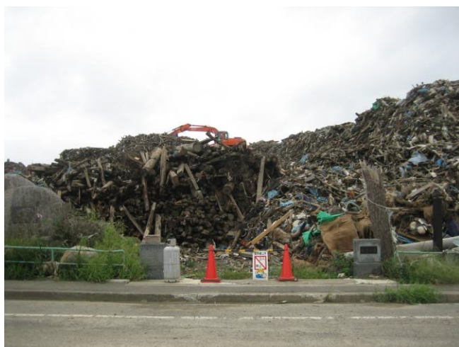
写真③；瓦礫の山
