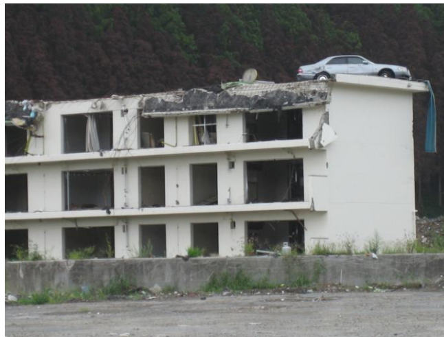
写真②；鉄筋の建物の上にある車
