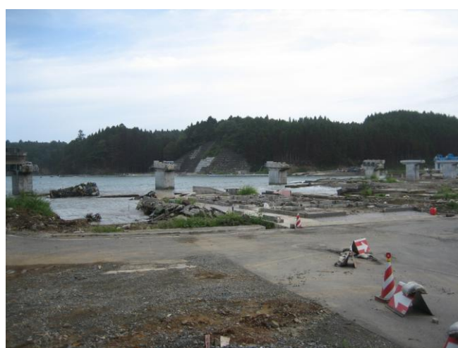
写真⑤；海沿いを走る鉄道気仙沼線の橋が崩落
